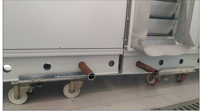
Şekil 12. Dış açılmış çubuk kullanarak bölümleri birleştirmek
