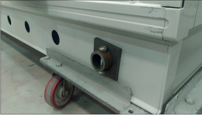
Şekil 7. Kaldırma çubuklarının bağlanması - 3
